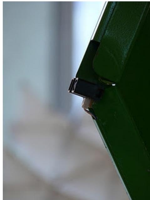
Figura 2 Sensores infrarrojos de proximidad incorporados a la pieza arquitectónica. Fotografías: Karol Bastidas
